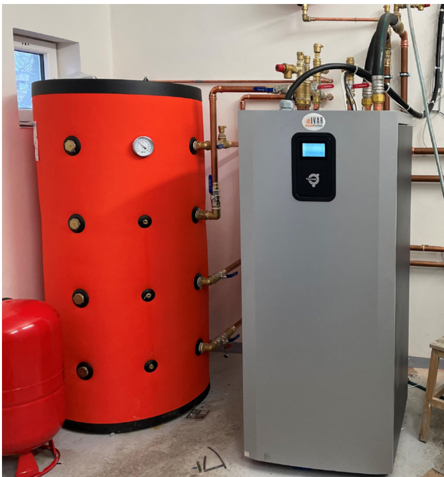
Tepelné čerpadlo typu země/voda (voda/voda) Thermia Mega S
